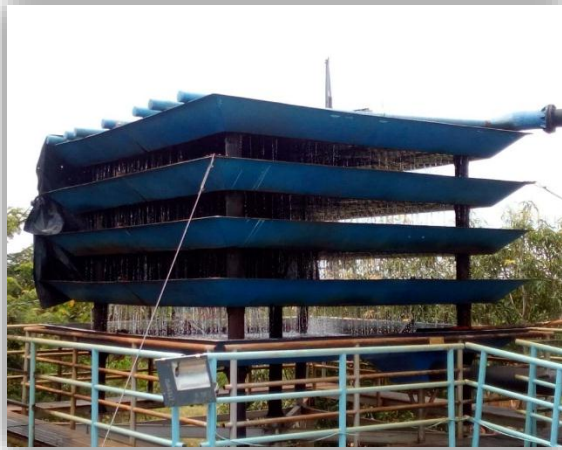
Fotografía: Torre de Aireación
