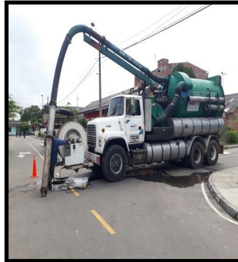
Limpieza del sistema alcantarillado con camión vector
