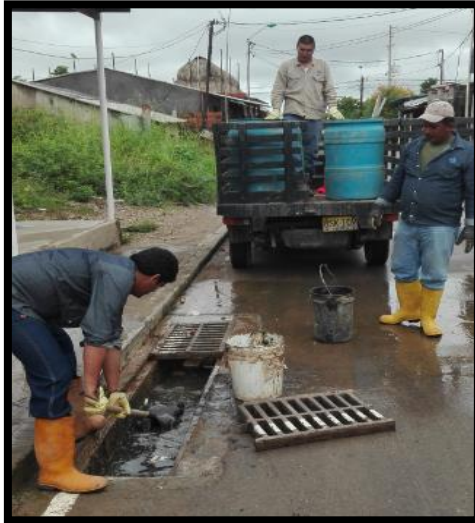
Mantenimiento Sistemas Hidráulicos Pluviales (Sumideros)
