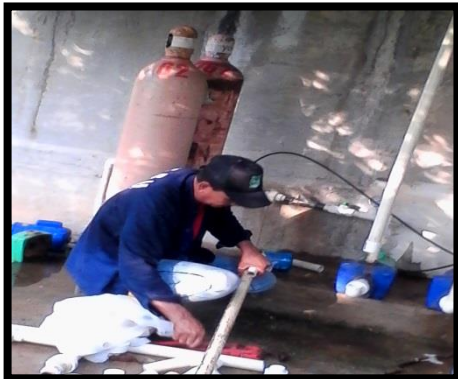
cambio de bombas de pre y post cloración
