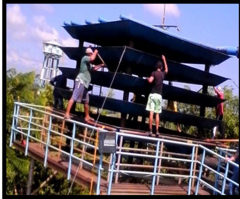
Lavado y cambio de materiales de la torre de aireación
