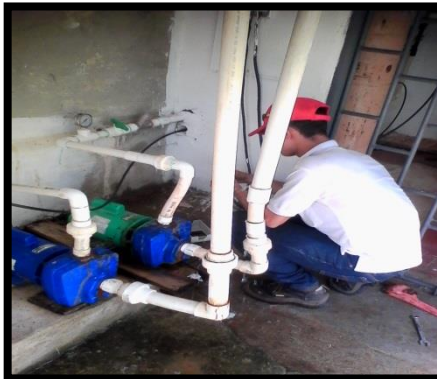
cambio de bombas de pre y post cloración
