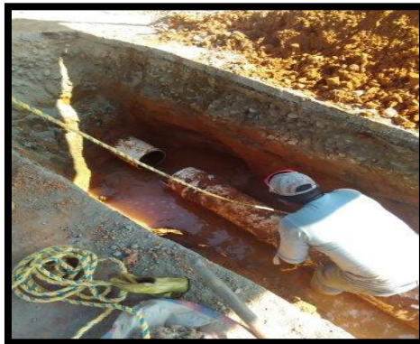
Reparación de daños
