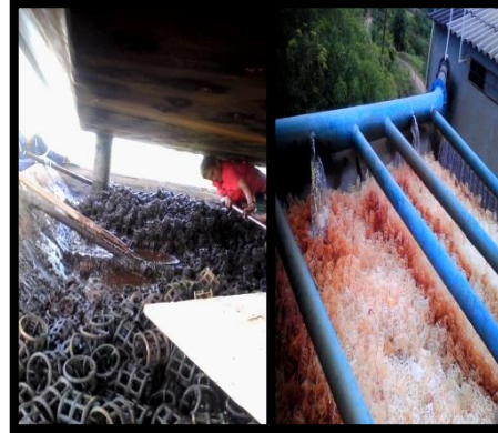
Lavado y cambio de materiales de la torre de aireación
